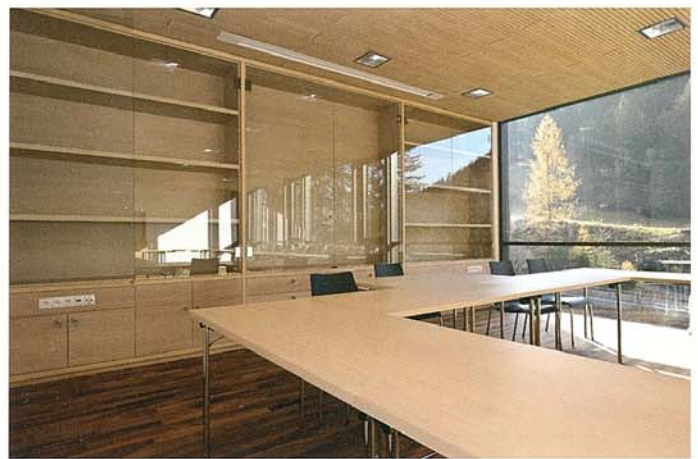
Bild 2. Raum mit schallabsorbierender Decken- und Wandverkleidung (Fotos: HOLTEG)
